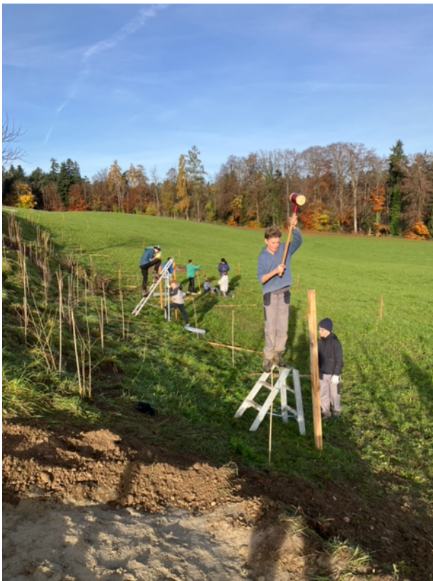
Einrammen der Pfähle für den Wildschutzzaun in Schönholzerswilen, 11. Nov. 2025
